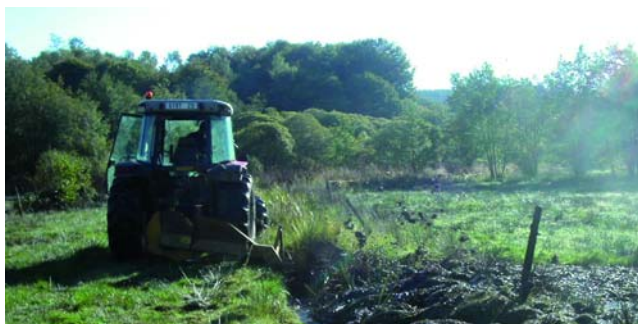
Rase réalisée à la rigoleuse. (photo ONEMA/Dubois L.)
