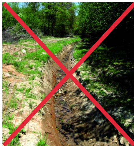
Fossé trop profond. (photo DDT/Szezurek)
