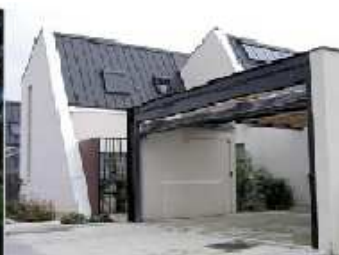
Hauts de Feuilly (Grand Lyon, source : CAUE 69)
