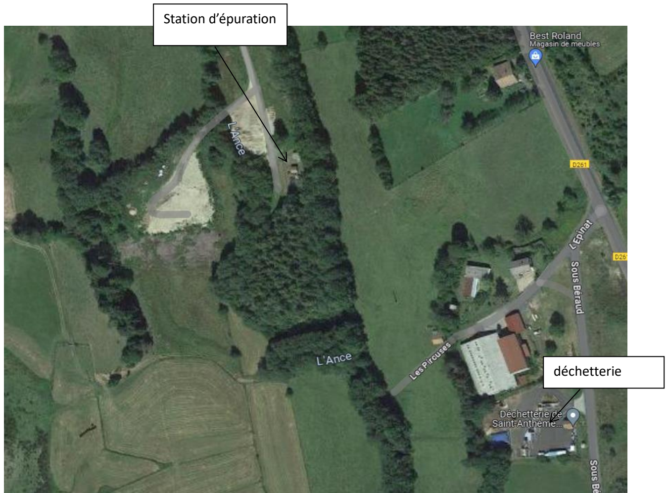
Vue aérienne des emplacements de la station d'épuration et de la déchetterie de Saint Anthème
