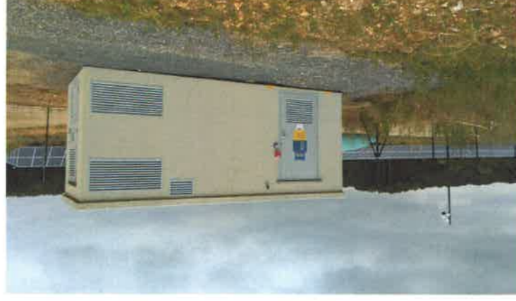
Figure 3 - Poste de Transformation/livraison en SOG SOLAR béton préfabriqué (source :
