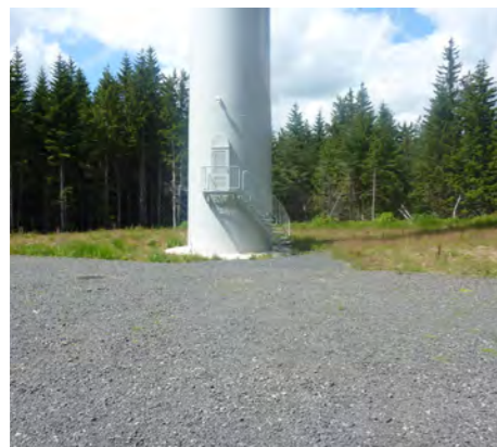
Fig. 20. Exemple de plateforme en phase d'exploitation d'un parc éolien en milieu forestier. Source: EDFen
