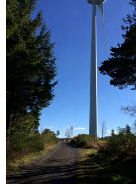
Fig. 19. Exemple de piste d'accès aux éoliennes en phase d'exploitation d'un parc éolien en milieu forestier. Vue immédiate d'une éolienne. Source: EDFen
