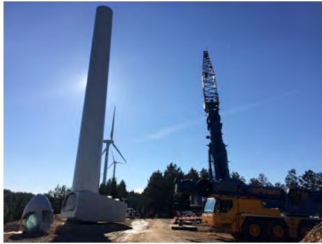
Fig. 14. Exemple de chantier de construction d'un parc éolien en milieu forestier. Piste, plateforme et grue. Source: EDFen
