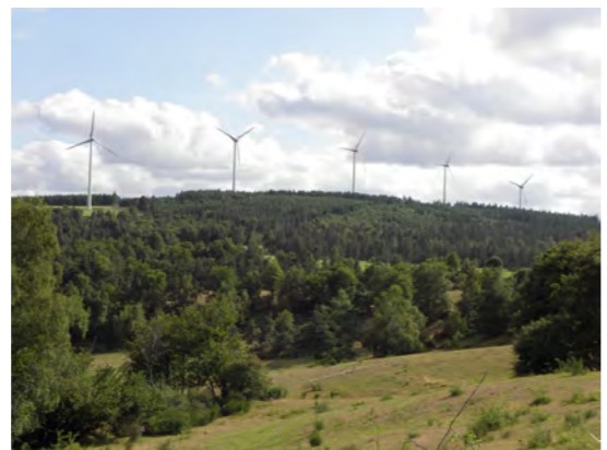
Fig. 21. Exemple de vue proche sur un parc éolien en milieu forestier. Source: EDFen
