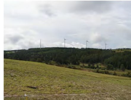
Fig. 16. Exemple de chantier de construction d'un parc éolien en milieu forestier. Vue du chantier depuis l'extérieur du massif forestier. Source: EDFen
