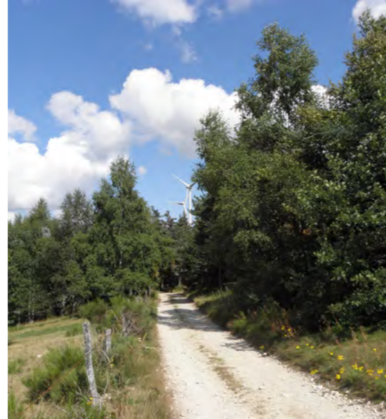
Fig. 18. Exemple de piste d'accès aux éoliennes en phase d'exploitation d'un parc éolien en milieu forestier. Vue des éoliennes d'échelle comparable aux arbres. Source: EDFen
