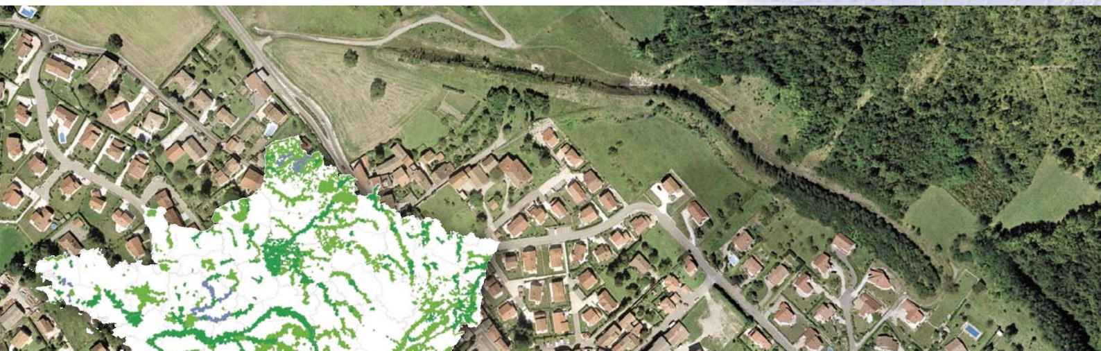
Un lotissement en pied de versant rocheux protégé par un long merlon pare-blocs.
