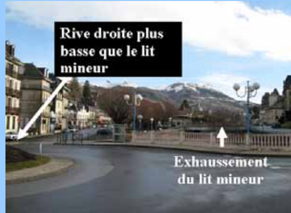
Photo 8 : lit en toit (lit mineur plus haut que la rive droite) (photo BCEOM)
