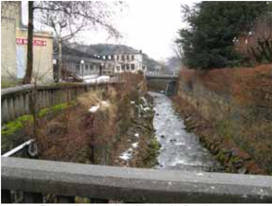
Photo 3 : canalisation de la Dordogne (capacité supérieure à la crue centennale) (photo BCEOM)
