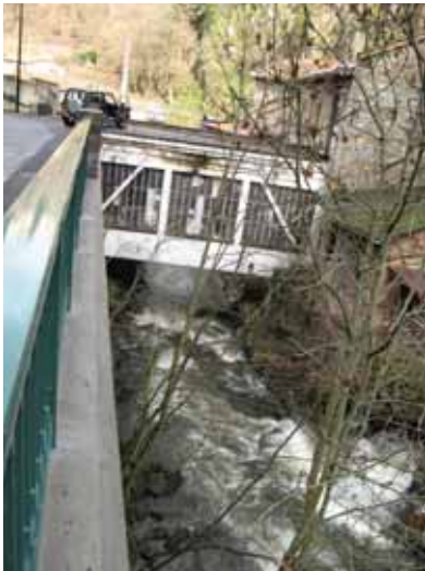
Photo 11 (point 4) : usine en zone inondable dans le secteur de gorges (amont de Thiers)
