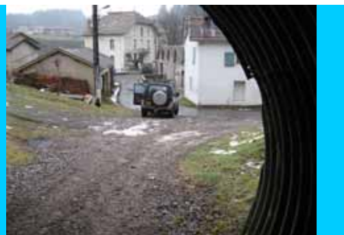
Photo 2 : Lieu dit « Chez le Car » (vue aval)
