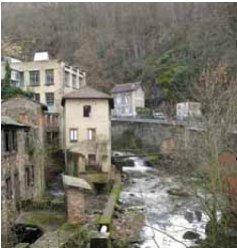
Photo 8 : secteur de gorge (source BCEOM)
