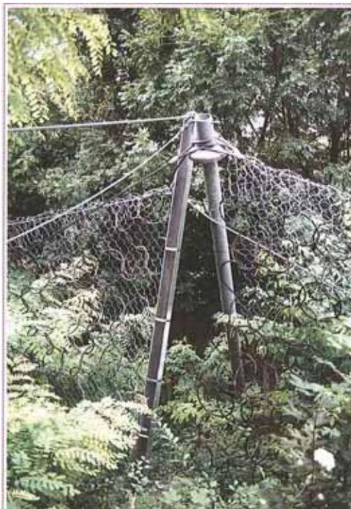
**Illustration 21 – Exemple de protection passive – écran déformable de filet**
