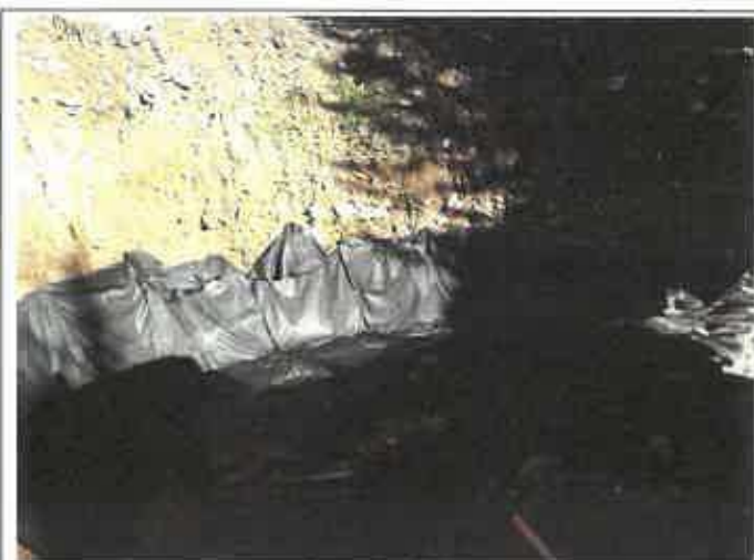
Géotextile de base
