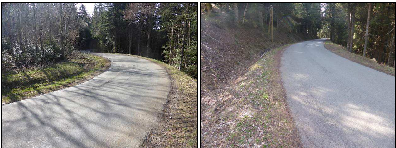
Fossé en accotement RD 40 montant au Col du Béal en amont du captage de « La Sablière »
