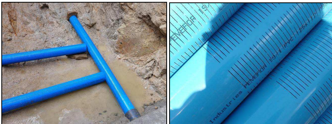
Captage avec tubes et crépines usinées en PVC alimentaire normalisé (source : Dyka Pevefor)
