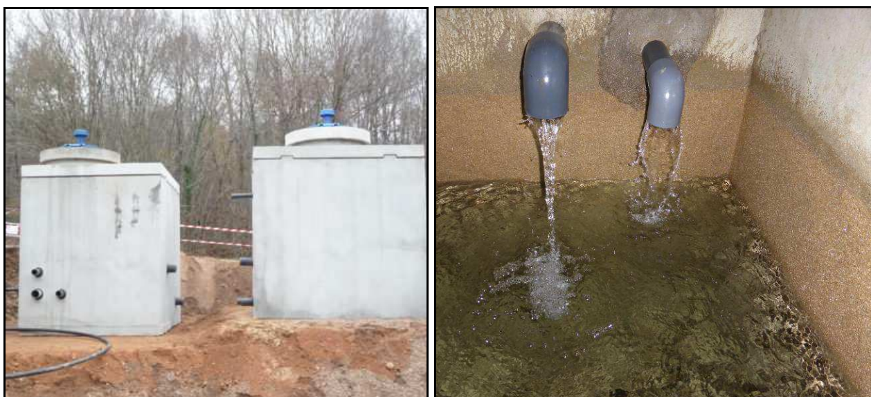
Regard de captage béton maçonnés ou préfabriqués (source : Bell'Eau), avec chambres humide et sèche
