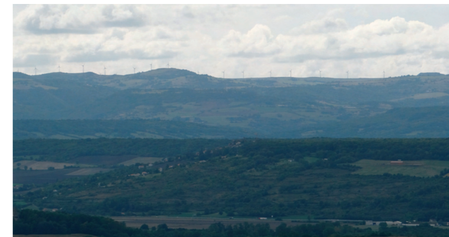
Fig.112. Parc éolien de Saulzet vu depuis la butte d'Usson.
