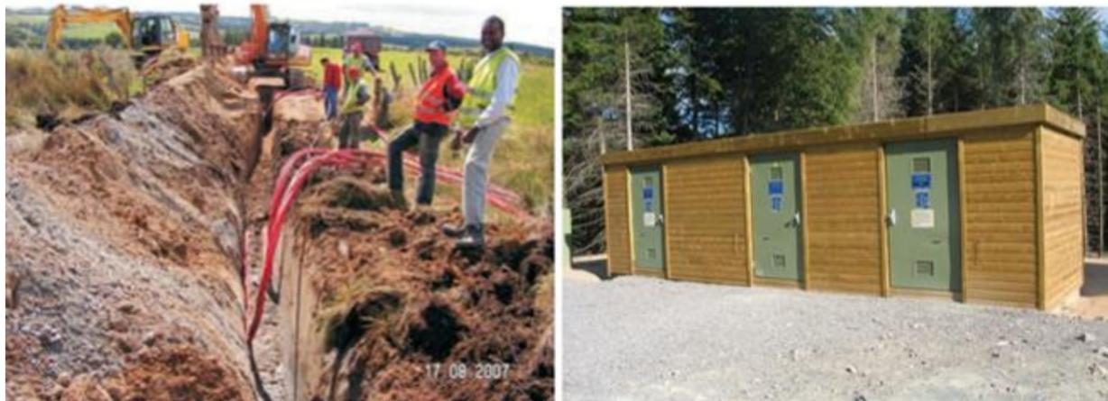
Photographie 8 : Déroulage et pose des câbles (à gauche), poste de livraison (à droite)
