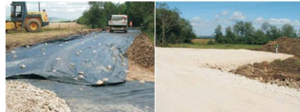
Photographie 4 : Pose d'un géotextile (à gauche), état final d'une plate-forme (à droite)
