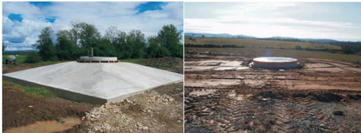
Photographie 6 : Massif béton terminé (à gauche), état final après remblaiement (à droite)
