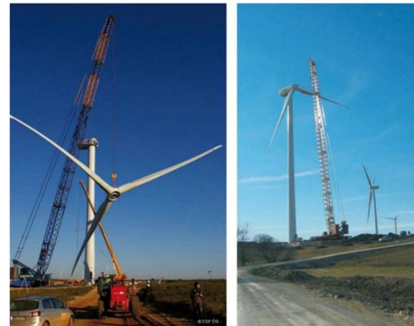
Photographie 7 : Montage du rotor (à gauche), montage « pale par pale » (à droite)
