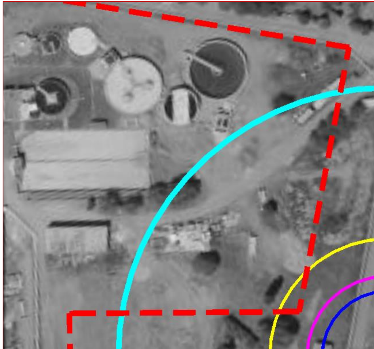
Figure 55 : Vue rapprochée des zones impactées par l'explosion de la chaufferie
