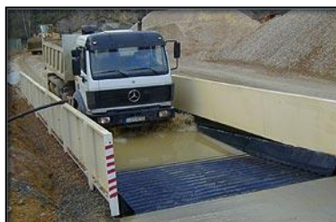
Aire de lavage des roues
