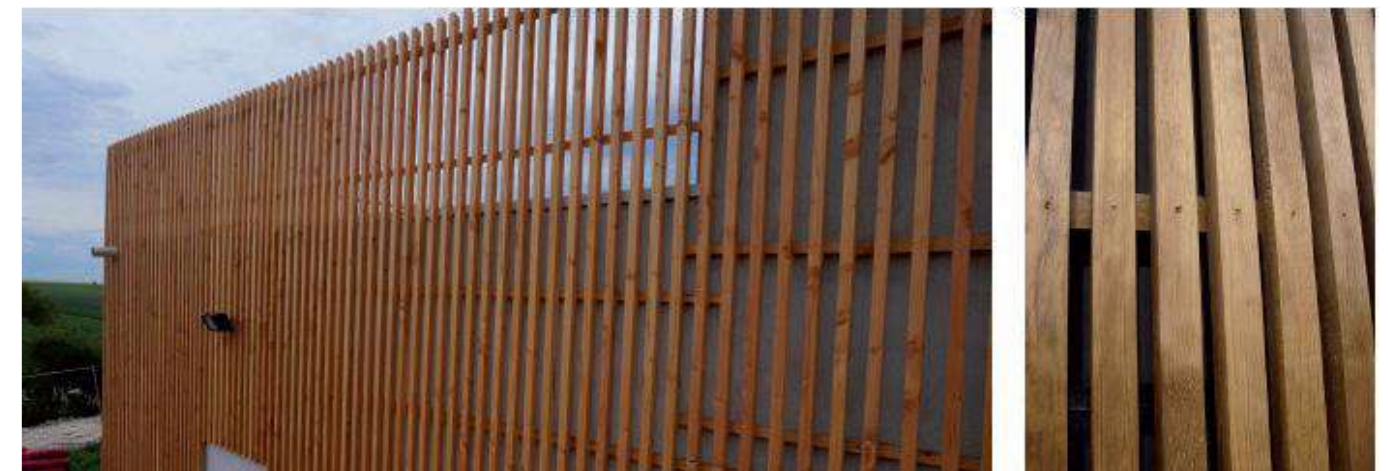
Photographie 111 : Exemple de bardage bois à claire-voie vertical garantissant l'intégration paysagère du poste de livraison tout en évitant l'installation des chiroptères attirés par le confinement.
