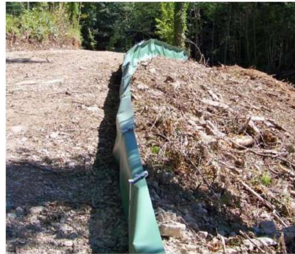
Photographie 109 : Exemple de bâche mise en place (Source : CERA Environnement)
