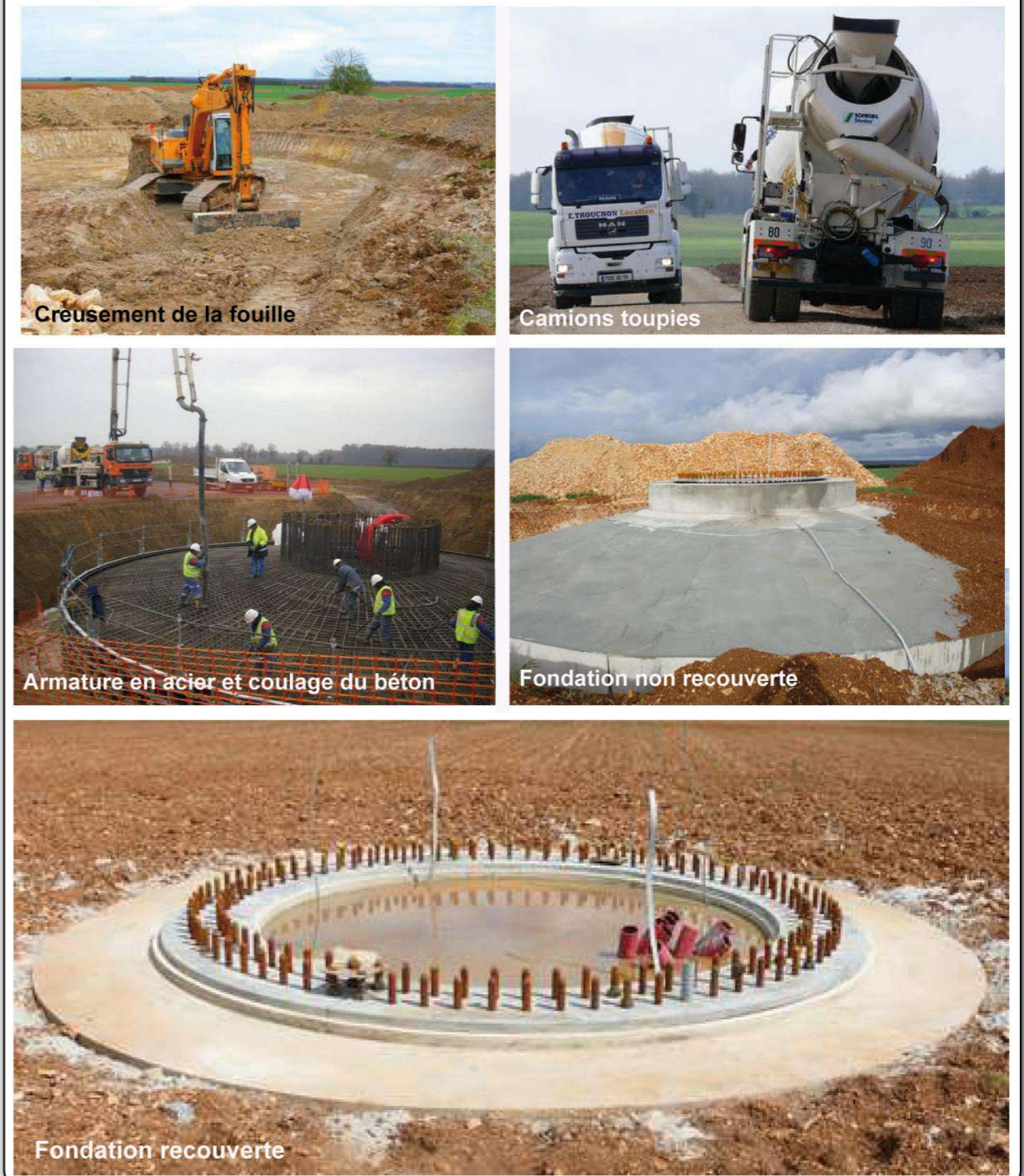
Photographie 79 : Etapes de réalisation d'une fondation d'éolienne
