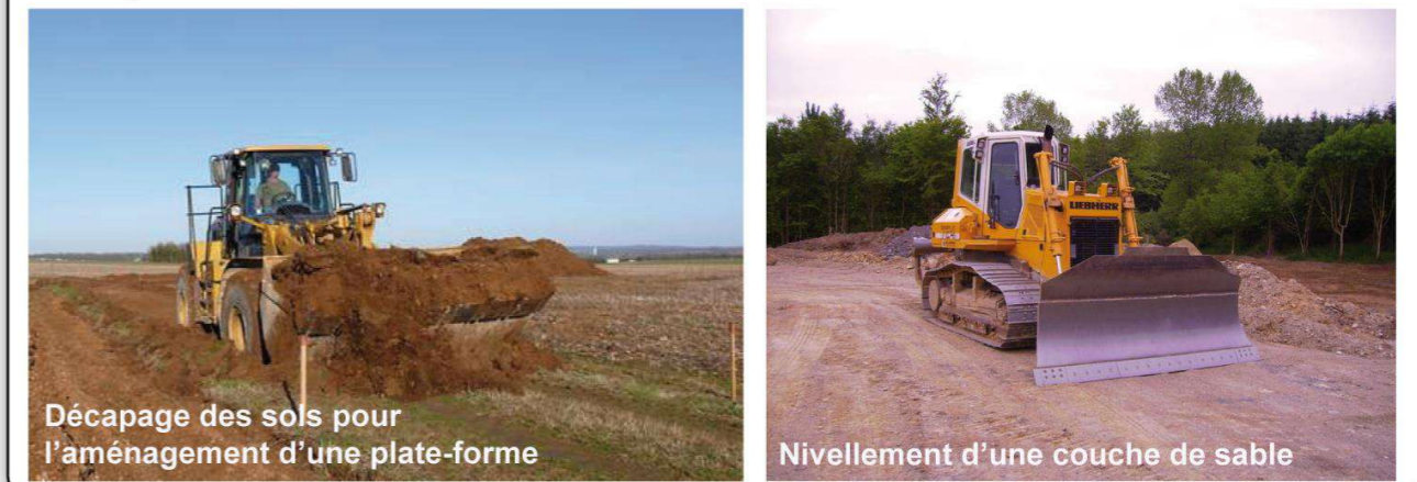
Photographie 78 : Exemples d'engins de travaux de VRD
