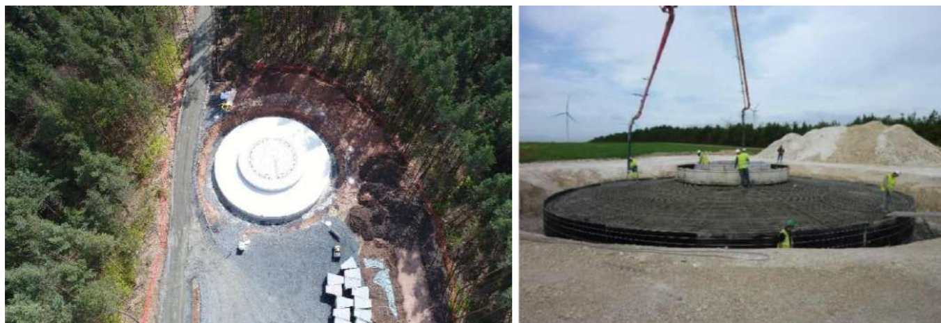
Photographie 73 : Travaux pour une fondation (source : ABO Wind)
