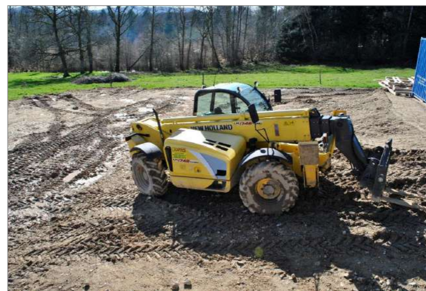
Photographie 82 : Exemple de tassement et d'ornières créés par les engins de chantier
