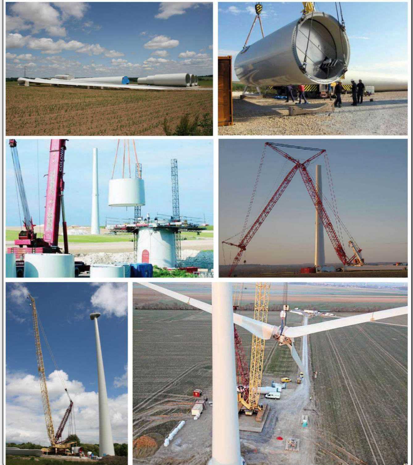
Montage d'une éolienne
