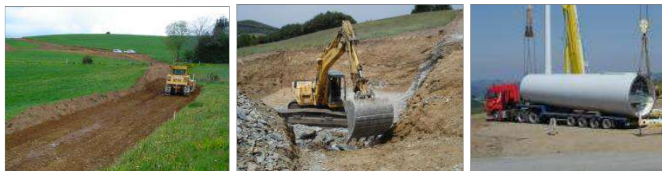
Photographie 85 : Illustration d'un chantier éolien
