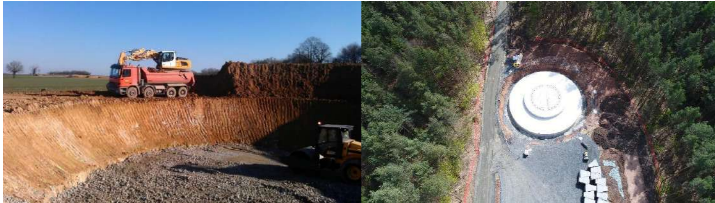
Figure 27 : Travaux pour une fondation (Source : ABO Wind)
