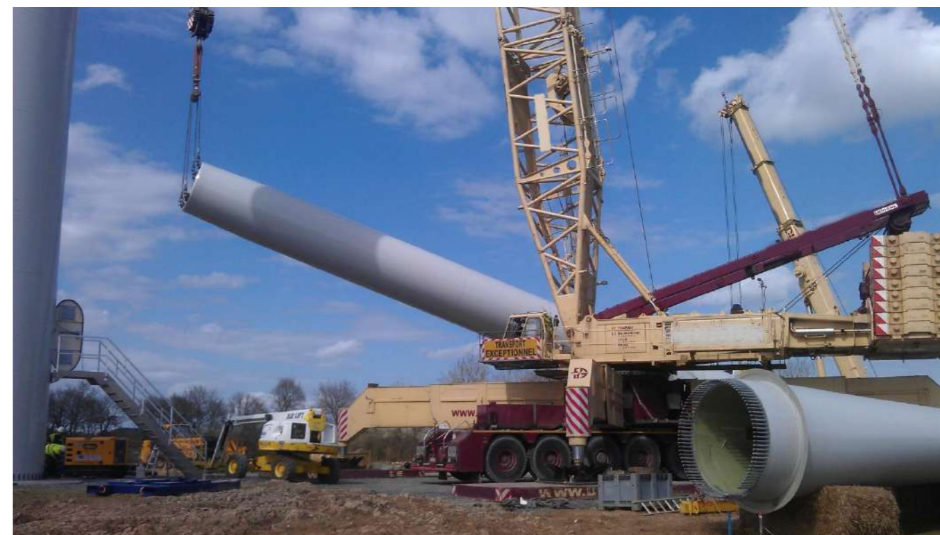
Photographie 77 : Grue de levage sur une plateforme (source : ABO Wind)
