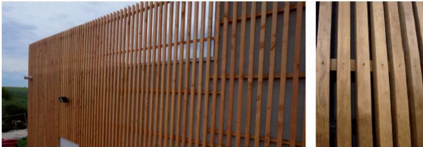
Photographie 74 : Exemple de bardage bois (Source : ENCIS Environnement)
