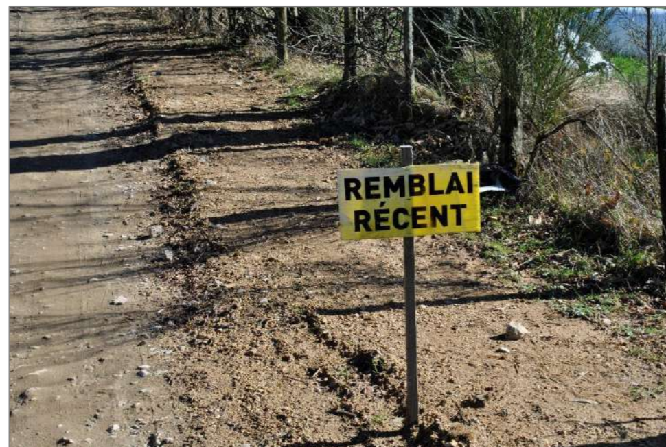
Photographie 83 : Exemple de remblai des tranchées électriques le long d'une piste (Source : ENCIS Environnement)
