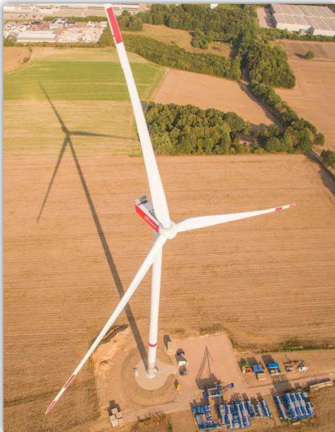
Photographie 72 : Eolienne NORDEX N149 (Source : Nawindpower)
