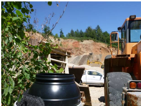
Vue de la station de mesure n° 3 en direction du site d'exploitation
