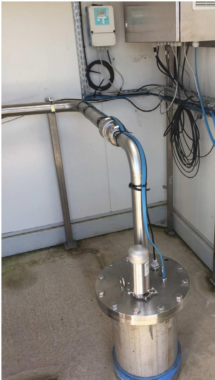
**Figure 4 : Forage SMS21 : Equipement de suivi de débit, pression, température et conductivité en aval de la tête de puits**
