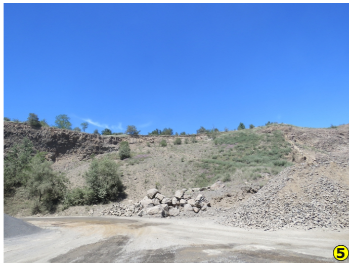
Secteur réaménagé au nord-est du site
