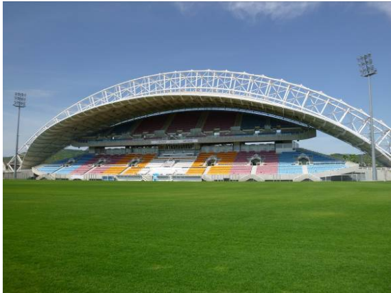
Figure 1 : Vue du stade et de la tribune Ouest
