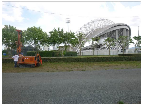
Figure 30 : Vue de la réalisation du sondage ST18
