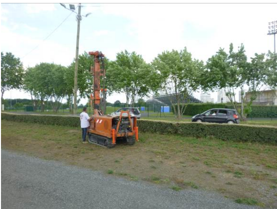
Figure 29 : Vue de la réalisation du sondage ST18
