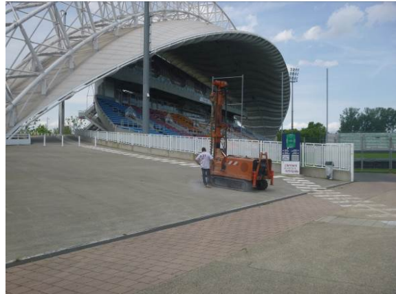
Figure 20 : Vue de la réalisation du sondage ST10
