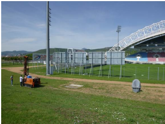
Figure 15 : Vue de la réalisation du sondage ST7
