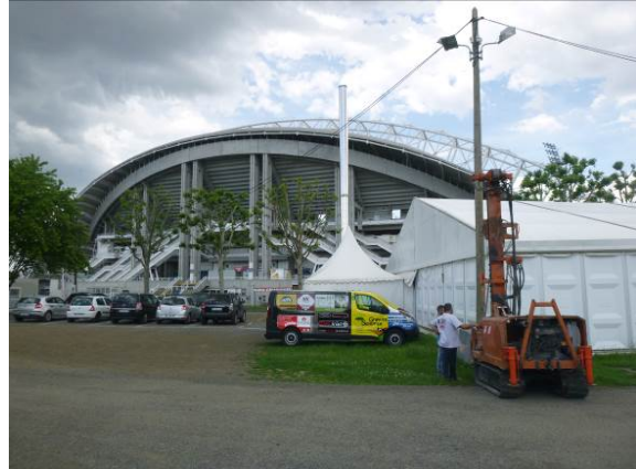
Figure 26 : Vue de la réalisation du sondage ST16
