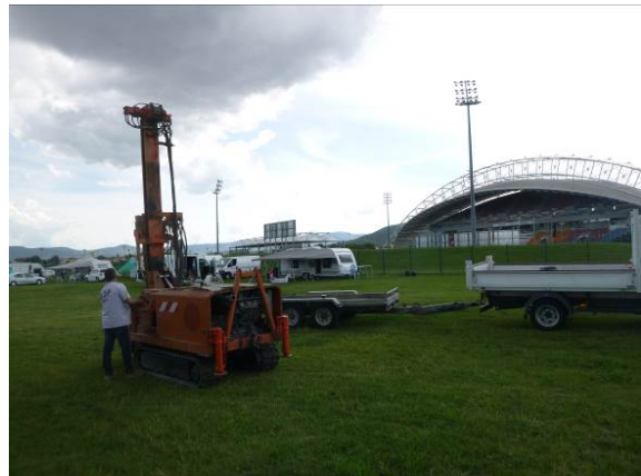
Figure 22 : Vue de la réalisation du sondage ST12
