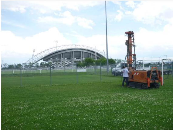
Figure 31 : Vue de la réalisation du sondage ST19
