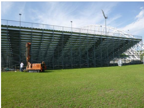
Figure 5 : Vue de la réalisation du sondage ST2 sur l'arrière de la tribune modulaire Nord
