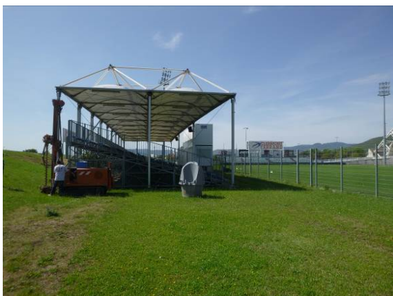
Figure 11 : Vue de la réalisation du sondage ST5 au droit de la tribune modulaire Est
