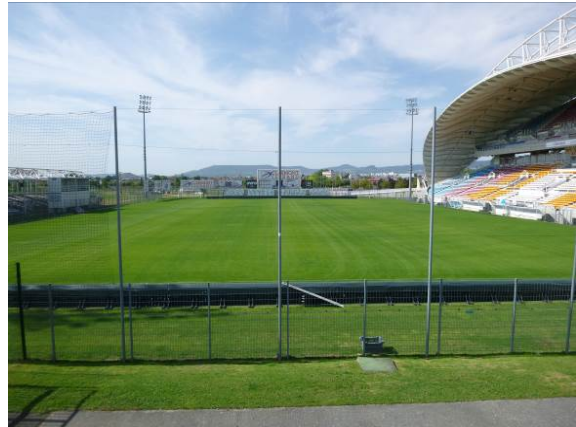
Figure 2 : Vue du stade depuis la tribune modulaire Nord
