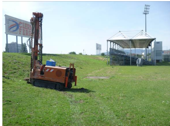
Figure 10 : Vue de la réalisation du sondage ST4
