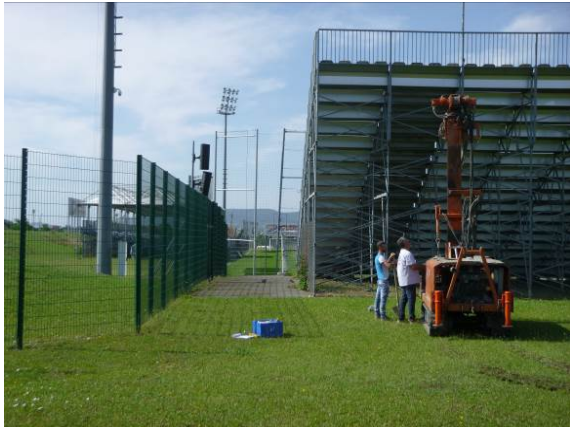
Figure 7 : Vue de la réalisation du sondage ST3 sur l'arrière de la petite tribune modulaire Nord
