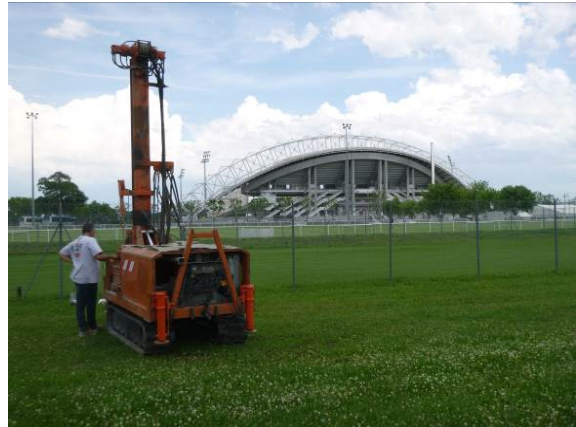
Figure 32 : Vue de la réalisation du sondage ST20
