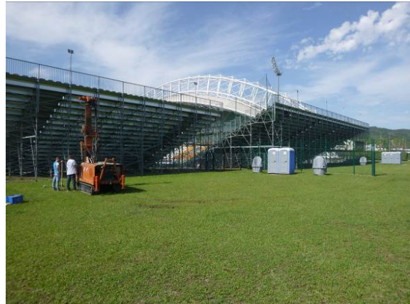
Figure 8 : Vue de la réalisation du sondage ST3 sur l'arrière de la petite tribune modulaire Nord
