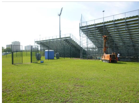
Figure 6 : Vue de la réalisation du sondage ST2 sur l'arrière de la tribune modulaire Nord
