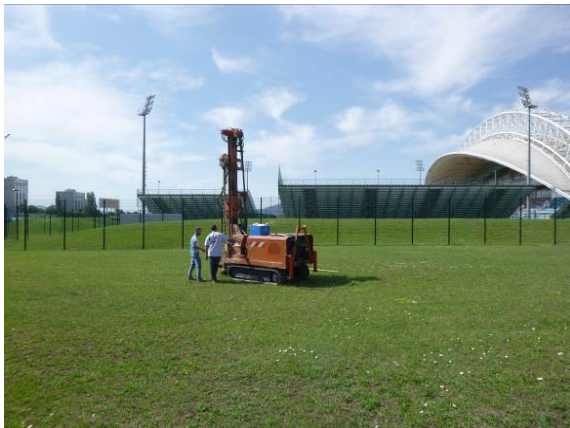
Figure 21 : Vue de la réalisation du sondage ST11
