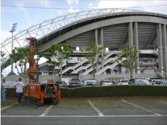
Figure 27 : Vue de la réalisation du sondage ST17
