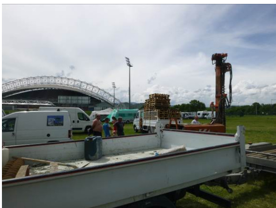
Figure 23 : Vue de la réalisation du sondage ST13
