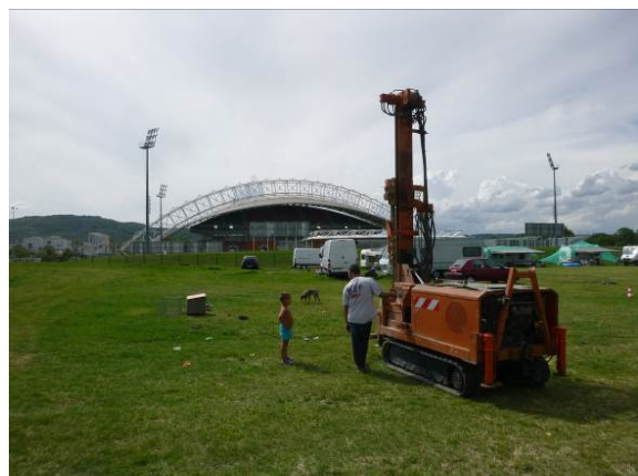
Figure 24 : Vue de la réalisation du sondage ST14
