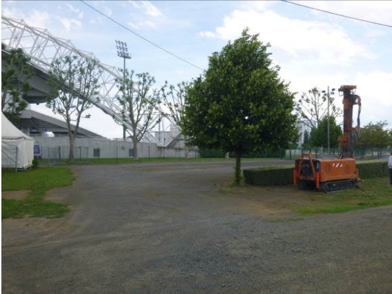
Figure 25 : Vue de la réalisation du sondage ST15
