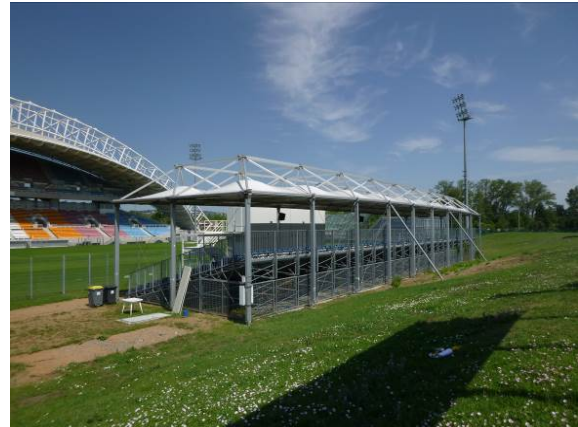
Figure 14 : Vue de l'emplacement du point de sondage ST6 réalisé à l'angle de la tribune modulaire Est
