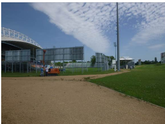
Figure 17 : Vue de la réalisation du sondage ST8
