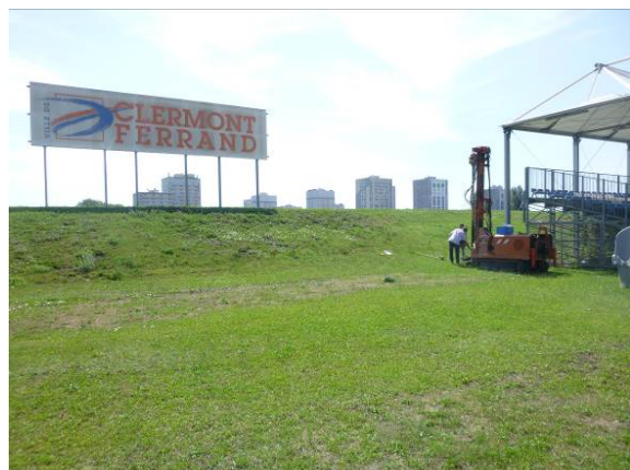
Figure 12 : Vue de la réalisation du sondage ST5 au droit de la tribune modulaire Est
