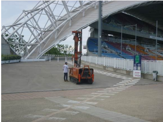
Figure 19 : Vue de la réalisation du sondage ST10
