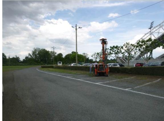
Figure 28 : Vue de la réalisation du sondage ST17
