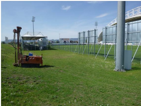
Figure 9 : Vue de la réalisation du sondage ST4
