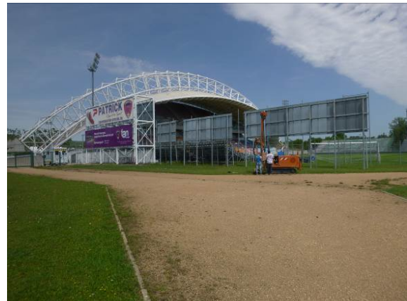
Figure 16 : Vue de la réalisation du sondage ST8
