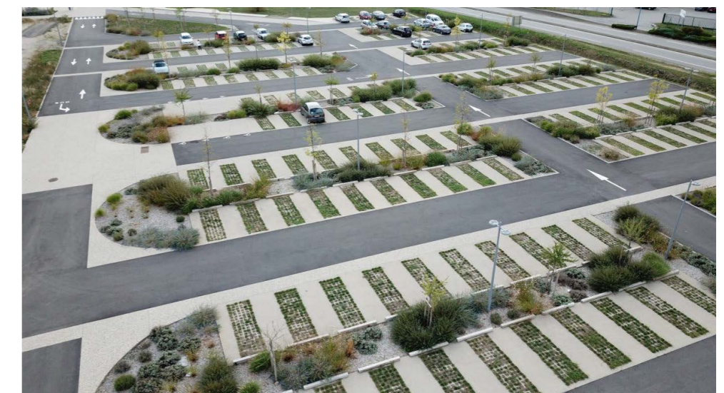
NOUES PLANTÉS AU COEUR DES STATIONNEMENTS
