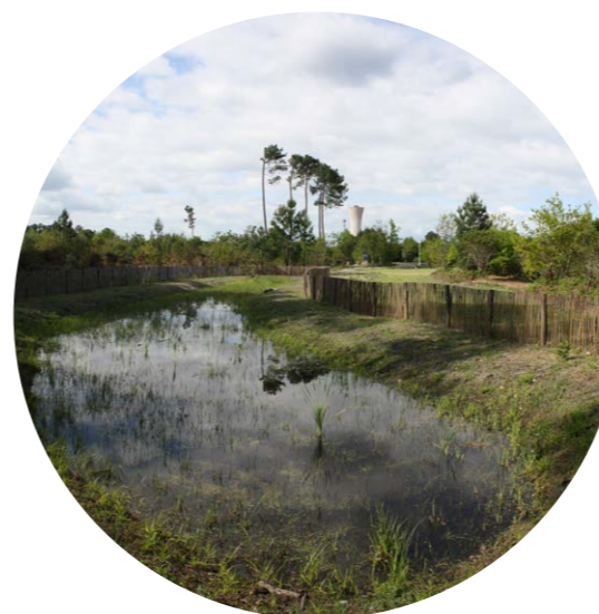
LE BASSIN DE RETENTION DES EAUX DE PLUIE
