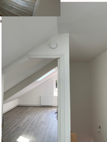
Rénovation à Thiers 2020 - DDT63
