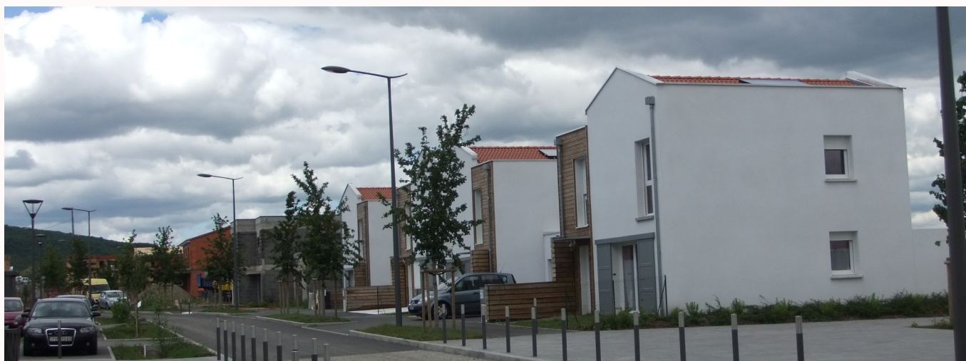
Compacité des habitations – DDT63
