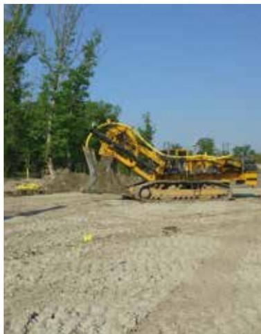
Installation des drains avec une sous-soleuse
