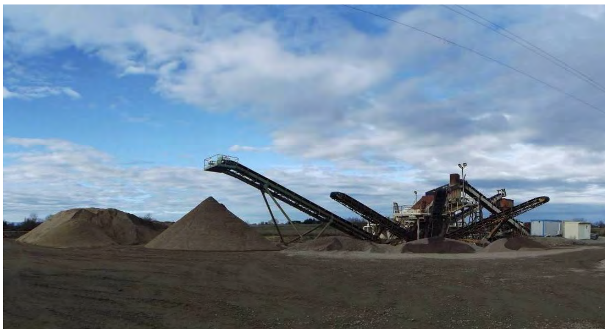
Installation de traitement des matériaux existante sur le Bloc 1 L'installation de traitement sera similaire
