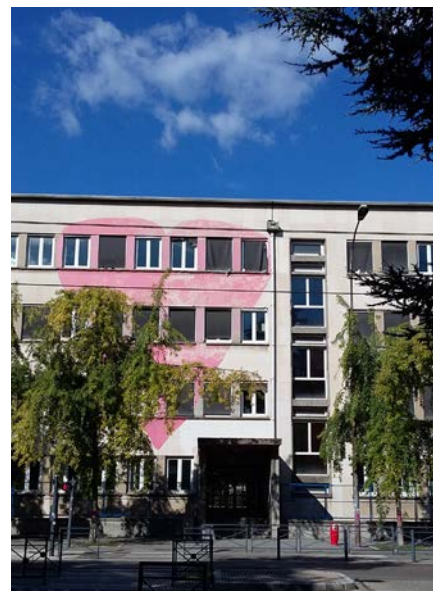
6,97 M€ DE FRANCE RELANCE POUR LA DÉMOLITION ET LA RECONSTRUCTION COMPLÈTE DU LYCÉE EMMANUEL MOUNIER - GRENOBLE (38)
