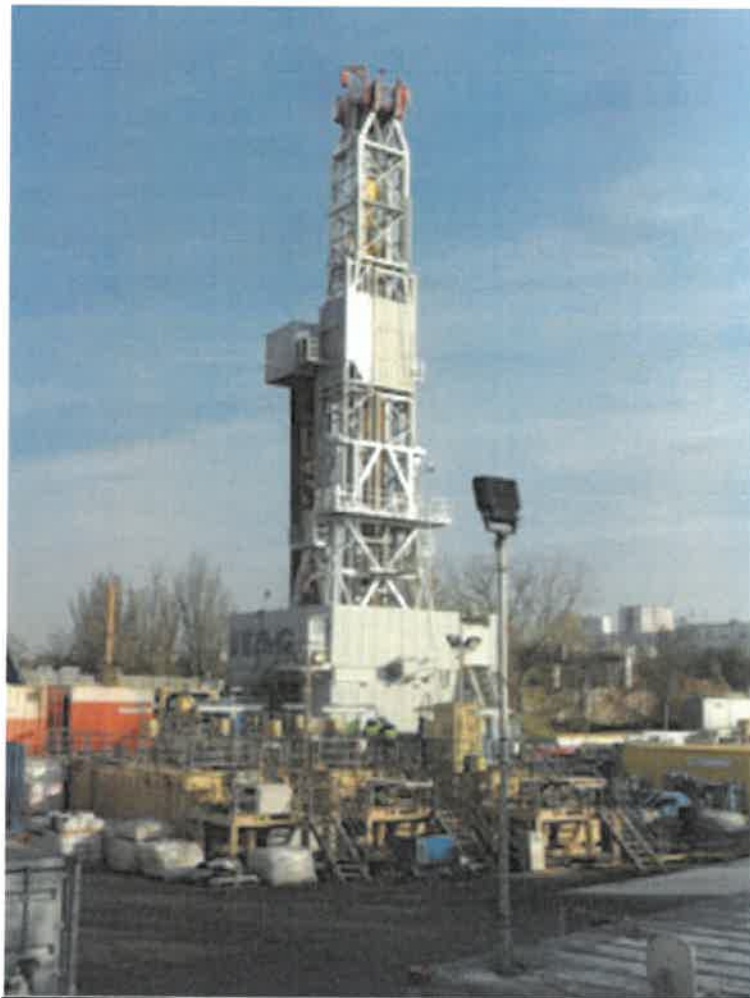
Site de forage Storengy à Arcueil (94)
