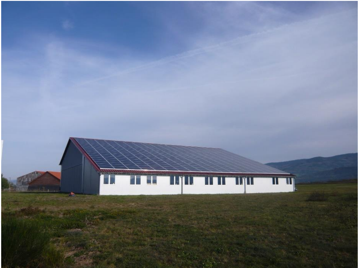
Figure 51 : Panneaux photovoltaïques sur l'un des bâtiments de l'aérodrome d'Ambert – Poyet.
