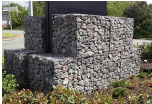
Figure 20 : Exemple de muret en gabion
