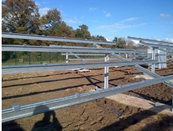
Figure 15 : Exemple de chantier de construction – pose de structures (Crédit photo : SERGIES, 2015)
