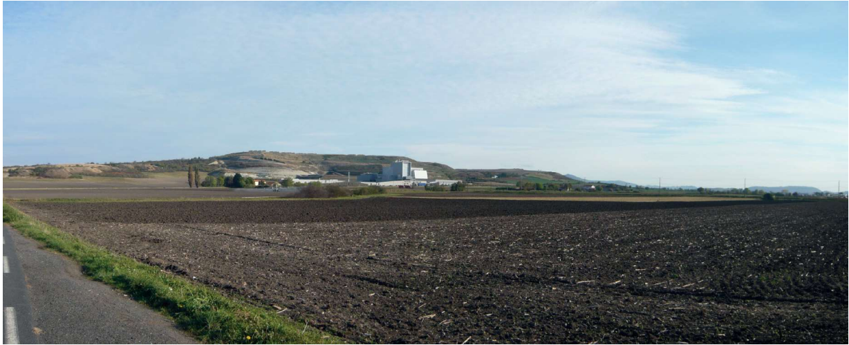
Figure 17 : Vue nord-ouest près de l'autoroute A711
