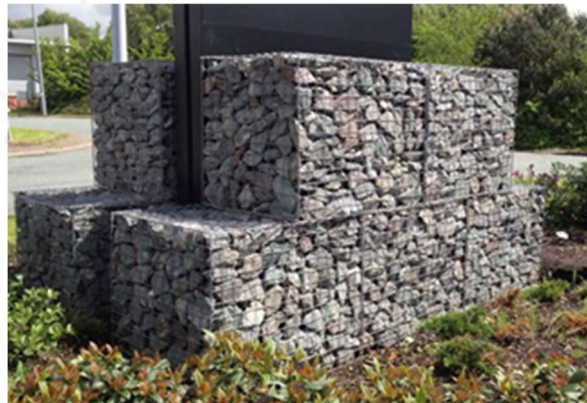
Figure 19 : Exemple de muret en gabion
