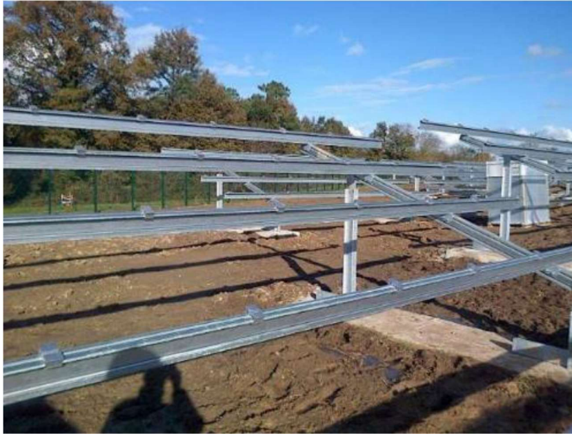
Figure 14 : Exemple de chantier de construction – pose de structures (Crédit photo : SERGIES, 2015)
