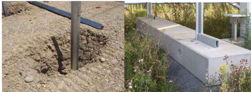
Figure 17 et 18 : Types de fondation - pieux battus (gauche) et semelle béton (droite)
