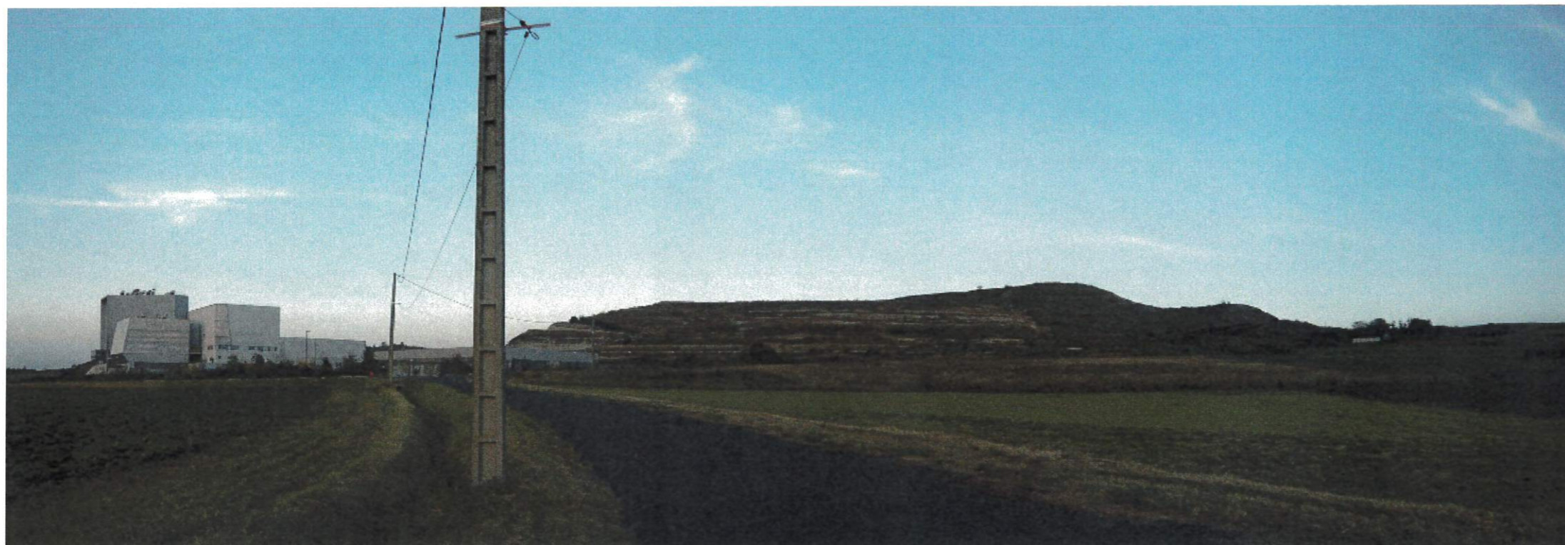
Le Puy Long et l'usine de traitement de déchets
