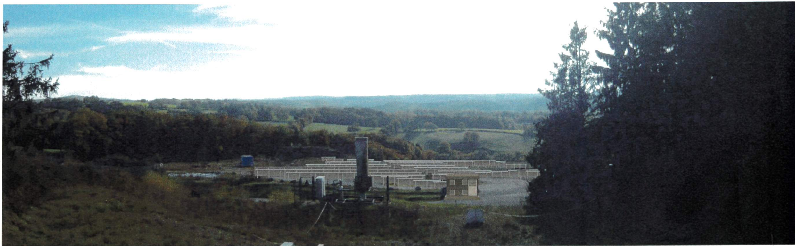
Vue depuis la route d'accès au nord après l'implantation du projet
