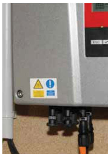
■ À gauche : présence d'un onduleur signalée par les étiquettes normalisées ■ À droite : exemple de signalétique visible à la limite de la concession ErDF
