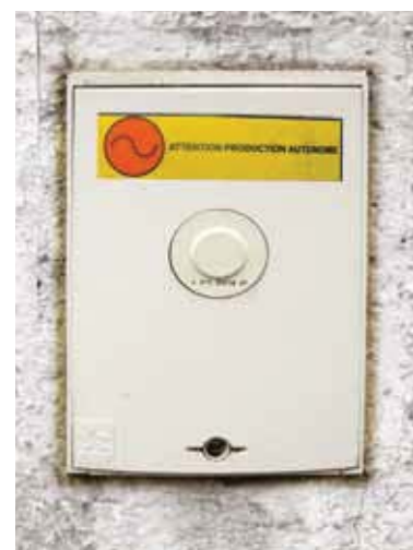
■ À gauche : présence d'un onduleur signalée par les étiquettes normalisées ■ À droite : exemple de signalétique visible à la limite de la concession ErDF
