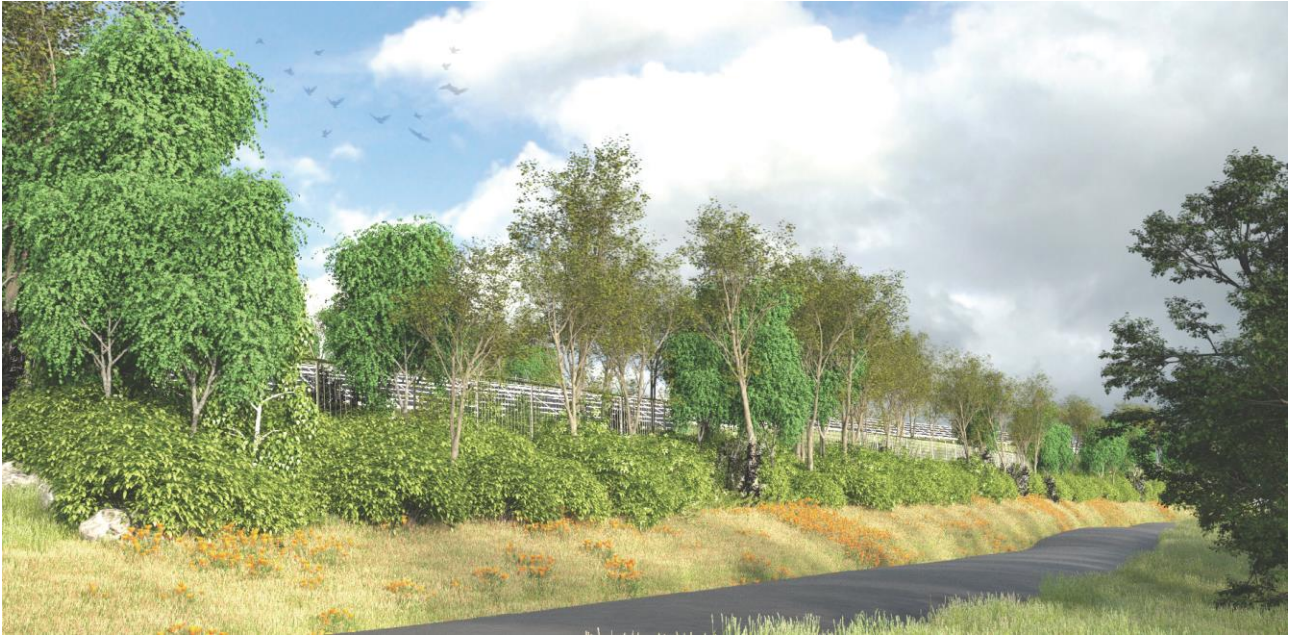
Figure 66 : Photomontage 6 (P6), vue depuis la RD47 vers l'est après mise en œuvre des mesures d'atténuation des impacts
