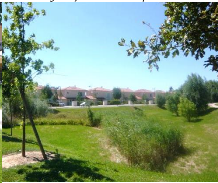
Bassin de rétention paysager
