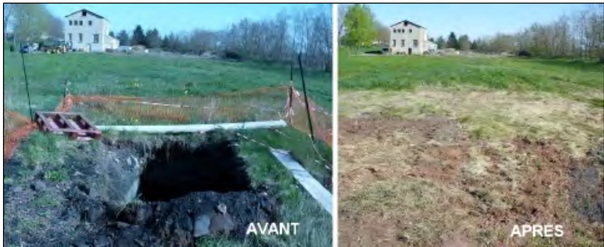
Figure 18 b : Mise en sécurité d'un fontis sur la galerie technique du puits Saint-Alexandre en avril 2014 (bétonnage et remblayage) (clichés DPSM)
