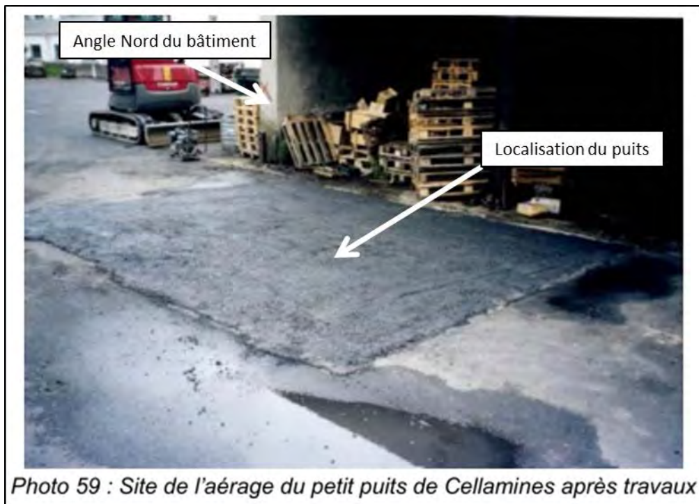
Figure 13 : Mise en sécurité du puits d'aérage du petit puits de Sellamines - cliché issu du DADT CdF
