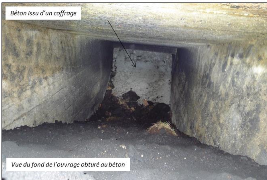
Figure 5 : Intérieur de l'ouvrage maçonné après dégagement à la pelle
