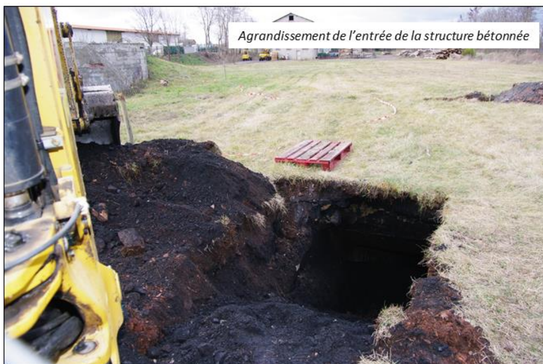
Figure 4 : Agrandissement de l'ouverture du fontis
