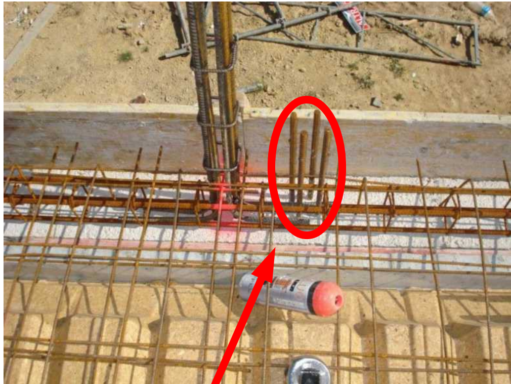
Attentes du chainage décalées
