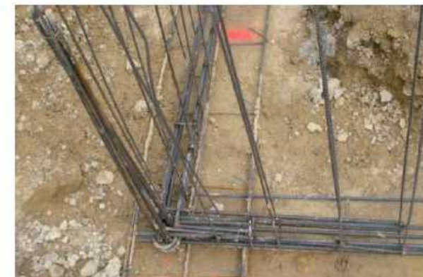
Noeud de chaînage - Continuité mécanique
