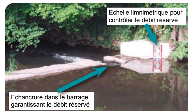
Barrage avec échancrure
