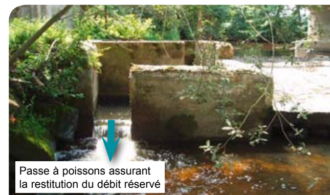
Barrage avec passe à poissons
