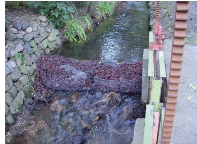
filtre en gabion de pouzzolane
