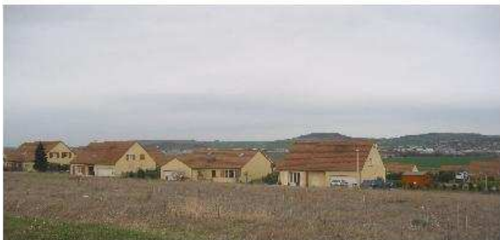
Construction neuve en périphérie : Source photographique DDE 63
