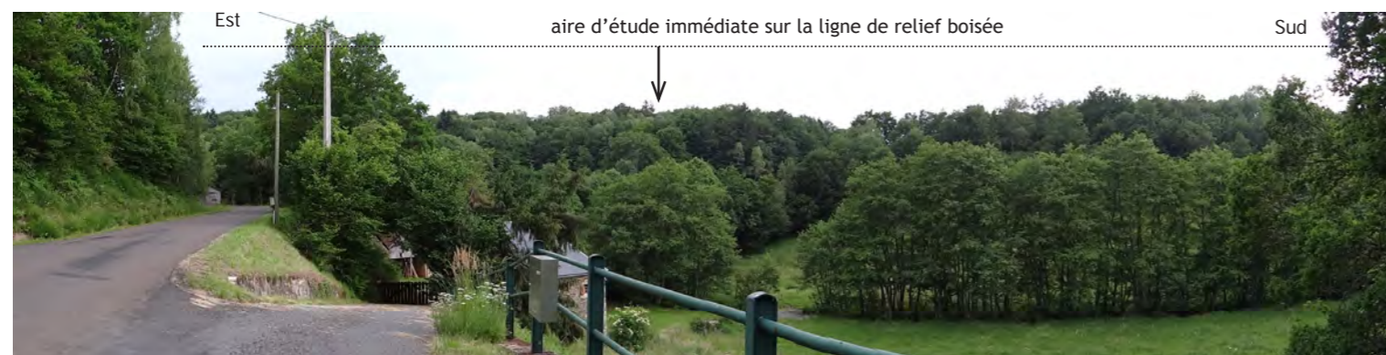
Fig.69. Vue vers le Sud Est depuis la RD11 au niveau du moulin de Taillefer dans la vallée du Petit Sioulet. Aire d'étude immédiate à environ 0,5 km.
