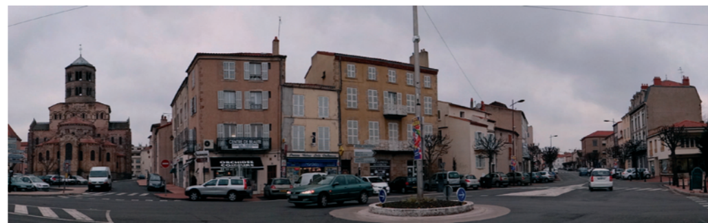
Fig.58. Vue proche sur l'abbatiale Saint-Austreimoine. Vue cadrée par le bâti. Pas d'enjeux visuels.
