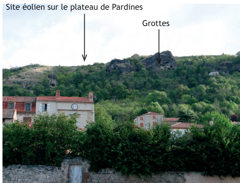
Fig.49. Grottes de Perrier vues depuis la place de l'église de Perrier sur la route RD996. Vue vers le Nord. Site éolien en arrière-plan sur le plateau de Pardines.
