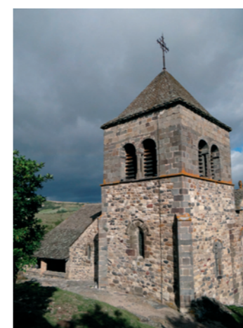
Fig.75. Eglise du Chastel de Saint-Floret.
