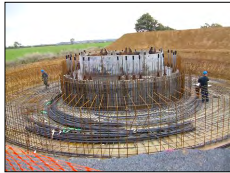
Ferraillage de la fondation
