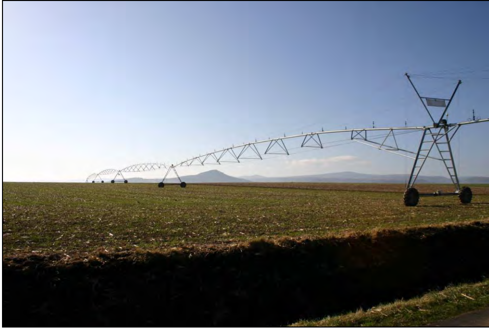
Photo 8 - Rampe d'arrosage sur le site éolien
