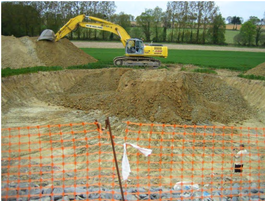
Photo 56 - Creusement d'une fondation d'éolienne
