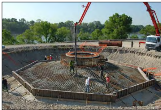
Coulage du béton
