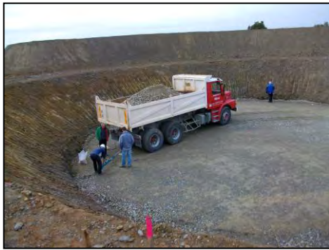
Fouille de la fondation
