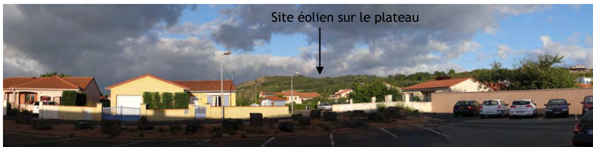
Photo 20 - Vue sur le site éolien depuis Issoire (maisons proches de la RD996 à la sortie ouest d'Issoire). Vue vers le nord-ouest.
