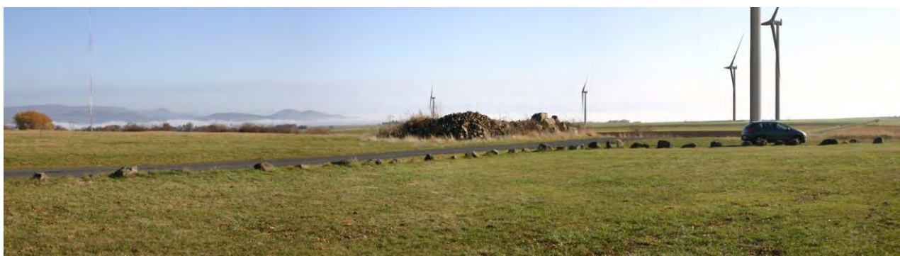
Photo 42 - Photomontage depuis l'aire de pique-nique à l'ouest du parc éolien (Environ 250 m de l'éolienne n° 1)
