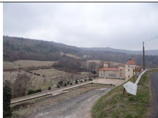
Photo 32 - Château de la Bâtisse
