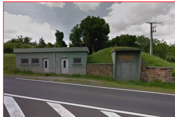
Figure 33 : Réservoir des Sagnes le long de la RD225
