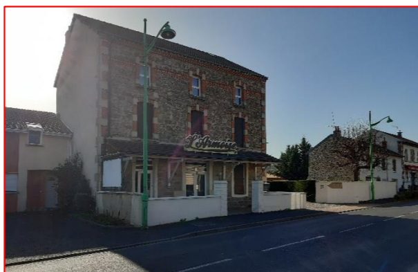
Figure 52 : Constructions à Longues le long de la RD225
