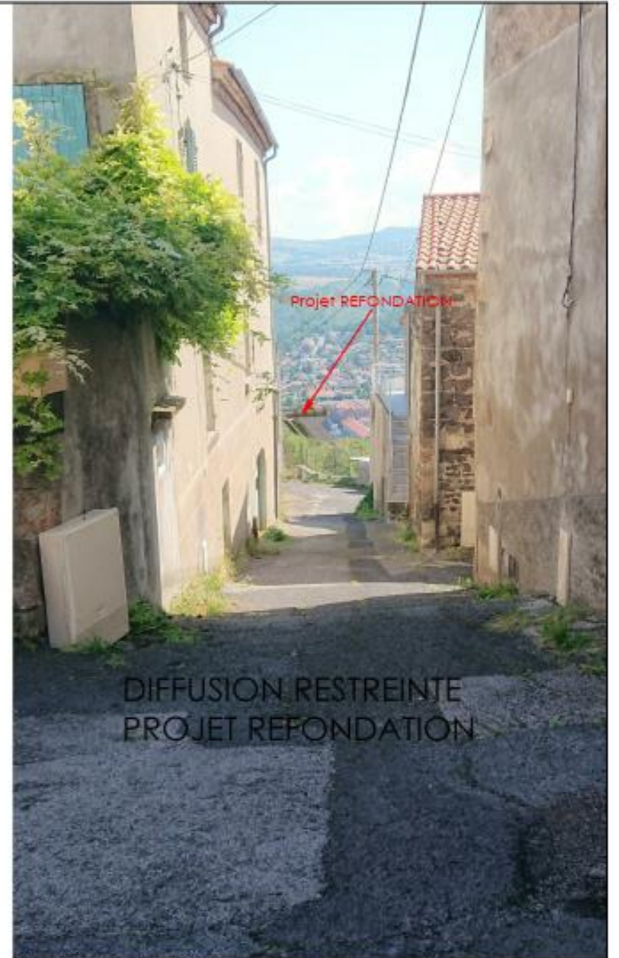
Vue d'insertion du projet
