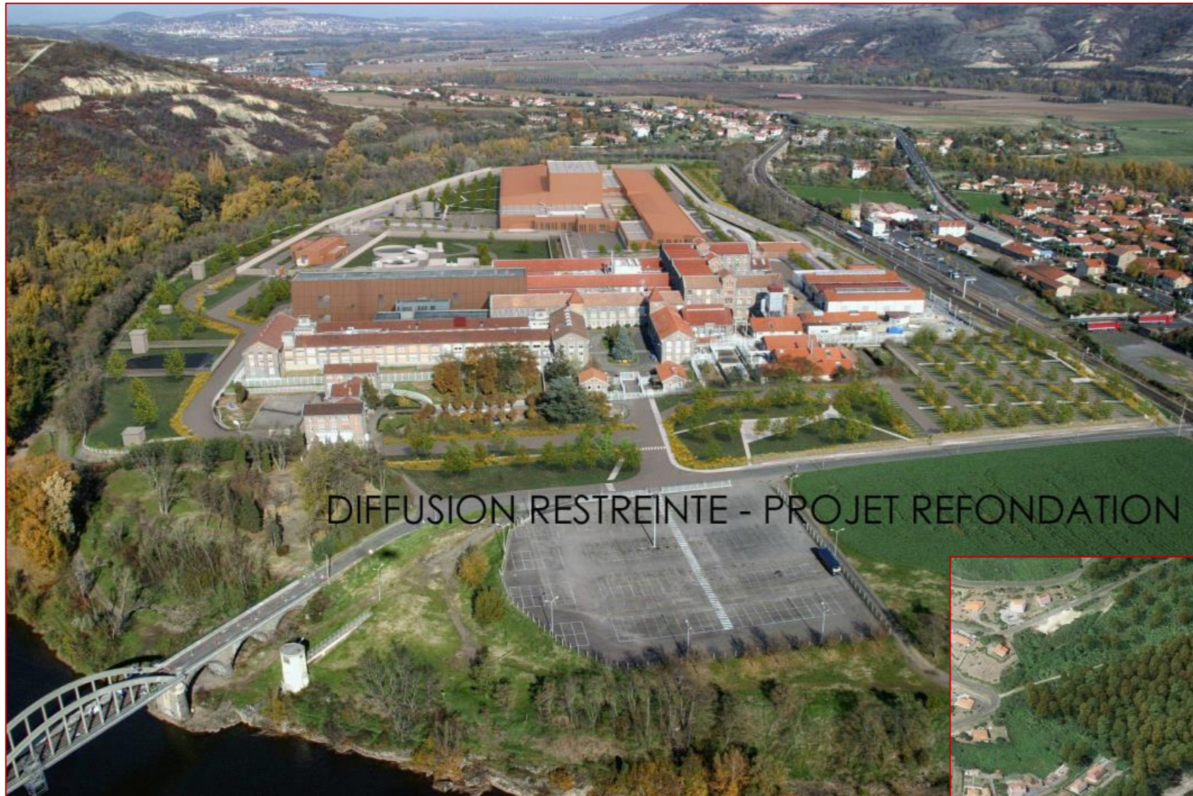
Figure 11 : Vue du site avec mise en œuvre du projet
