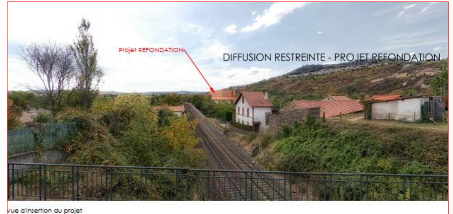
Vue depuis le pont SNCF
