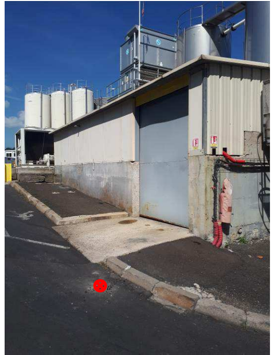
Photo 13 : stockage huiles neuves et usagées
