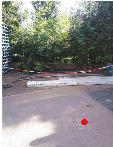
Photo 15 : séparateur hydrocarbures (S4)
