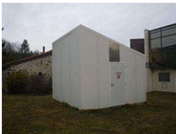
le bâtiment de protection
