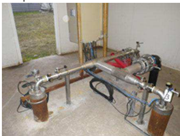
les têtes de forage
