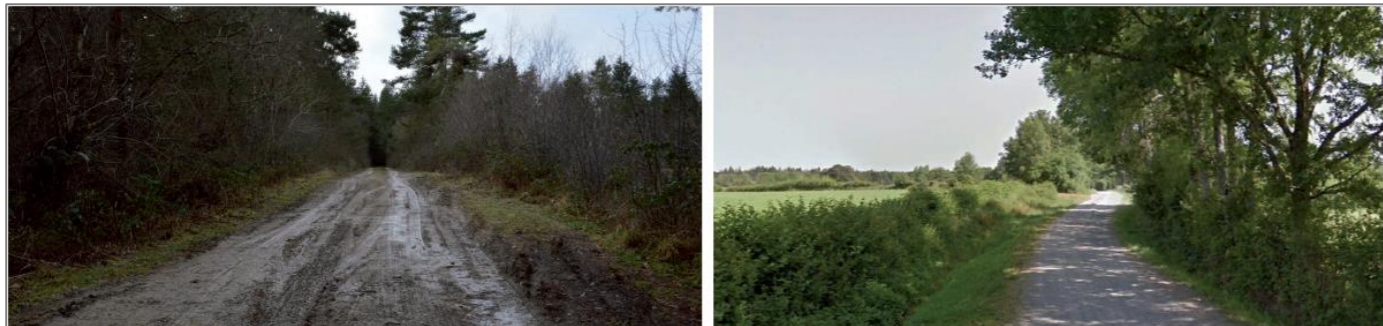
Photographie 37 : A gauche, chemin existant (accès à E2 et E3), à droite, piste existante (accès à E4)
